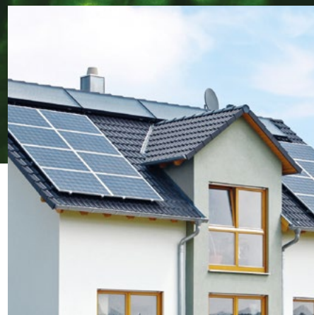
MODUŁY I INWERTERY FOTOWOLTAICZNE
